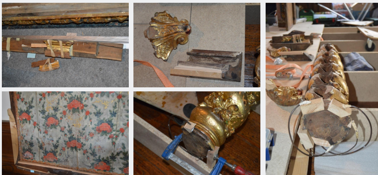
Fig. 28 a) - e): Alguns elementos tiveram que ser refeitos. Nos enxertos de madeira foi utilizada madeira de castanho, a mesma espécie da original. DETALHE, Conservação e Restauro de Mobiliário ©
