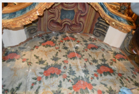
Fig. 50 a) - d): Execução de parte do desenho em falta nas tábuas do teto do nicho. DETALHE, Conservação e Restauro de Mobiliário ©
