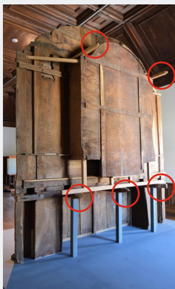
Fig. 33 a) - c): Sistemas de fixação de elementos do retábulo à parede. No retábulo da Sagrada Família, o sistema de entrega dos barrotes à parede seria o ilustrado ao centro. Os barrotes (assinalados na imagem da esquerda) seriam travados com cunhas de madeira. Na figura à direita está representado um outro sistema que frequentemente se encontra em altares com outro desenho e em que elementos estruturais eram pregados num taco de madeira introduzido na parede. Esses tacos de madeira eram frequentemente segmentos de ramos das árvores. DETALHE, Conservação e Restauro de Mobiliário ©
