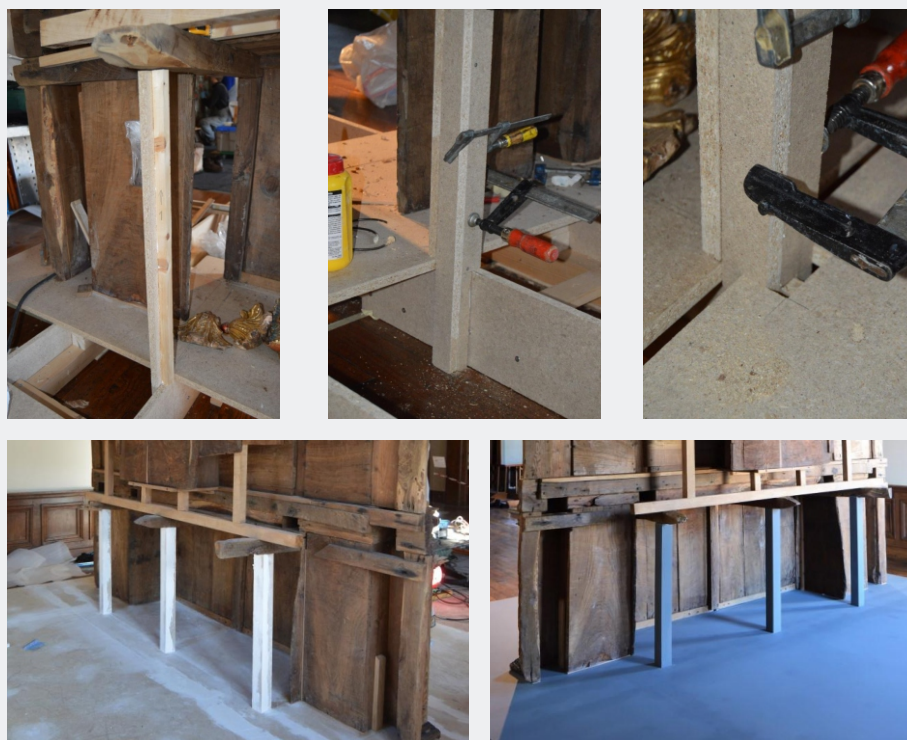
Fig. 45 a) - e): Apoios estruturais. A criação destes apoios foi necessária para conferir estabilidade ao conjunto. Os três barrotes horizontais que seriam, na sua função original fixos à parede, foram ligados aos elementos verticais do estrado através da introdução de um varão roscado inox. Estas escoras verticais de núcleo em madeira de pinho forradas no mesmo aglomerado de partículas do estrado seriam pintadas da mesma cor do estrado para de forma inequívoca distingui-los de qualquer elemento estrutural do retábulo. DETALHE, Conservação e Restauro de Mobiliário ©
