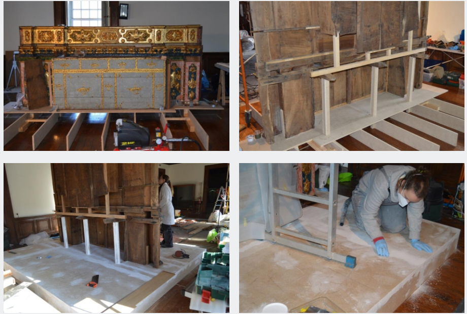
Fig. 58 a) - d): Execução do estrado e preparação para pintura. DETALHE, Conservação e Restauro de Mobiliário ©
