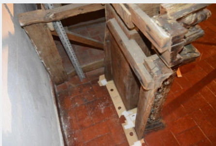
Fig. 14: Antes da desmontagem do retábulo, foi feito um molde do recorte da base para que no processo de montagem os elementos mantivessem a distância original entre estes. DETALHE, Conservação e Restauro de Mobiliário ©
