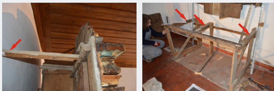
Fig. 32 a), b): Estruturas auxiliares executadas em madeira de pinho (à direita). Estes elementos terão sido introduzidos aquando da montagem anterior do retábulo proveniente do Convento das Chagas. A parte superior do retábulo é fixa à parede da sala através de dois barrotes (fig. à esquerda), sendo que na parte inferior se criaram uma série de travamentos na diagonal para conferir estabilidade ao conjunto, uma vez que os três barrotes inferiores não eram fixos à parede tal como o seriam originalmente (fig. direita). DETALHE, Conservação e Restauro de Mobiliário ©
