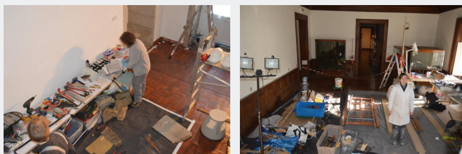
Fig. 13 a), b): Zona de trabalhos no piso térreo (esq.) e no piso superior (dir.). DETALHE, Conservação e Restauro de Mobiliário ©
