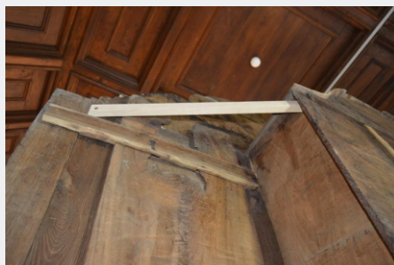
Fig. 42: Elemento de travamento do tramo lateral ao nicho. A introdução destes elementos é especulativa, mas existe frequentemente em retábulos com esta tipologia, além de que era essencial para a estabilidade do conjunto uma vez que os barrotes de cima não podiam ser fixos. DETALHE, Conservação e Restauro de Mobiliário ©
