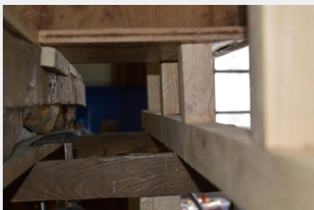
Fig. 41: Elementos de apoio do nicho. DETALHE, Conservação e Restauro de Mobiliário ©
