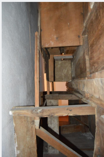
Fig. 8 a), b): Aspeto de elementos estruturais, não originais, e que foram aplicados para resolver um problema de estabilidade do conjunto, uma vez que os barrotes não foram fixos à parede. DETALHE, Conservação e Restauro de Mobiliário ©
