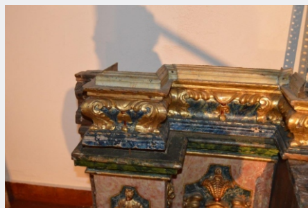
Fig. 34 a), b): Sistema de construção da banqueta. DETALHE, Conservação e Restauro de Mobiliário ©
