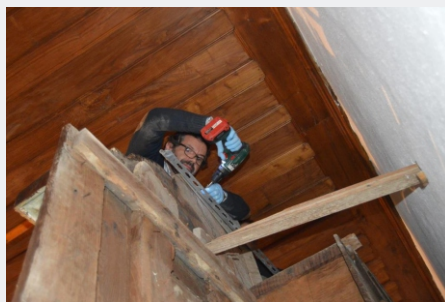
Fig. 15: Foram aplicados alguns reforços temporários nalguns elementos, evitando deformações e desmontagens desnecessárias. DETALHE, Conservação e Restauro de Mobiliário ©
