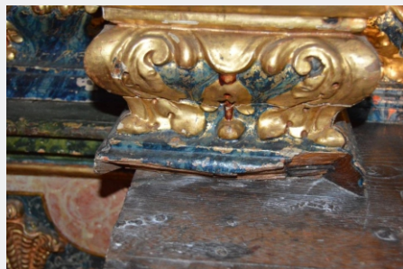
Fig. 6: Uma das faltas mais evidente é de parte de um segmento de moldado da banquetta. DETALHE, Conservação e Restauro de Mobiliário ©
