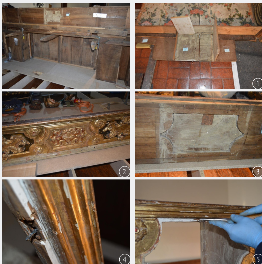
Fig. 60 a) - f): Portinhola, Caixa no nicho (1); Frente da portinhola inserida na predela (2); Verso da portinhola (3); Zona por onde era introduzido o estilete para acionar a lingueta (4); ajuste da portinhola (5). DETALHE, Conservação e Restauro de Mobiliário ©
