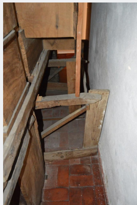
Fig. 8 a), b): Aspeto de elementos estruturais, não originais, e que foram aplicados para resolver um problema de estabilidade do conjunto, uma vez que os barrotes não foram fixos à parede. DETALHE, Conservação e Restauro de Mobiliário ©
