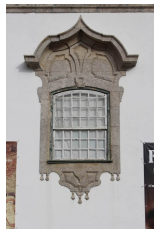
FOTOGRAFIA 7 Janela de guilhotina. Primeiro piso
