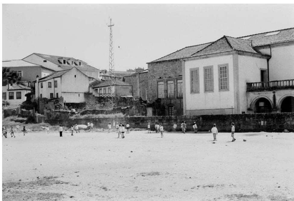
FOTOGRAFIA 12 Aspeto da fachada posterior, 1974. SIPA
