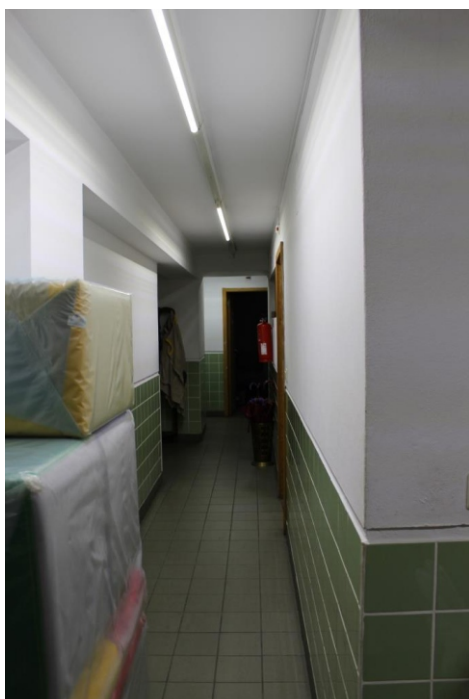
FOTOGRAFIA 18 Corredor. Articulação dos espaços internos, 2017
