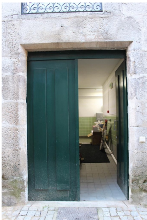
FOTOGRAFIA 16 Acesso secundário ao interior do edifício, 2017
