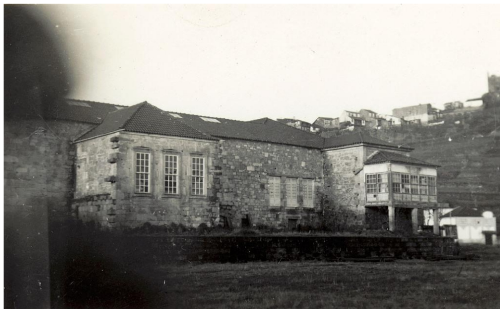
FOTOGRAFIA 11 Aspeto da fachada posterior, [s.d.] SIPA
