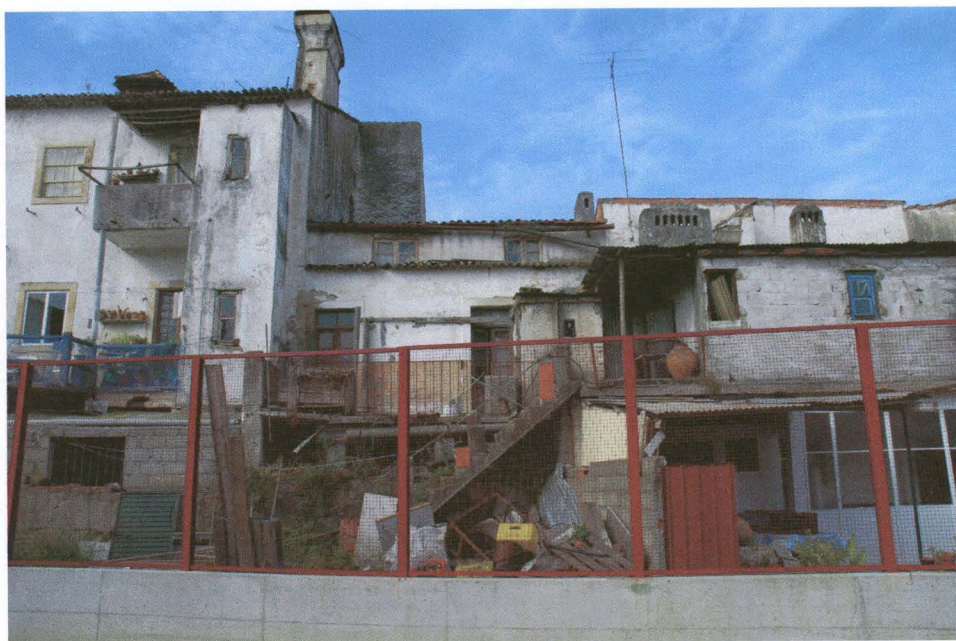
Casa na Rua de Baixo, 45, Santa Clara fachada traseira (nascente)
