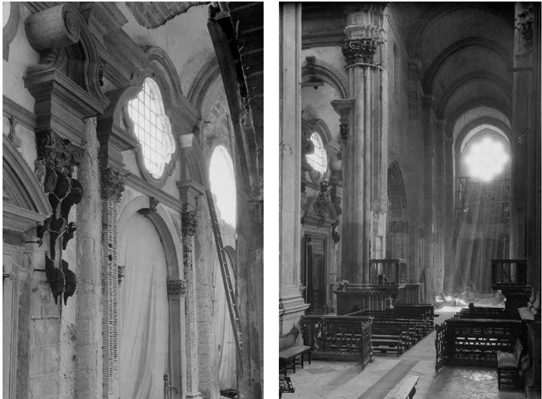
Nave lateral esquerda e nave principal (s.d., Património Cultural, I.P.©, s.a. 159 ).
