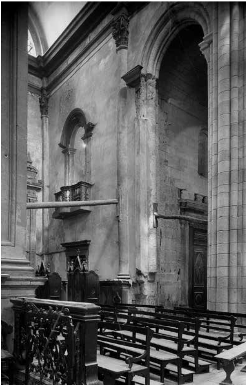
Pormenor da nave em obras junto ao transepto (s.d., Património Cultural, I.P.©, s.a. 163 ).
