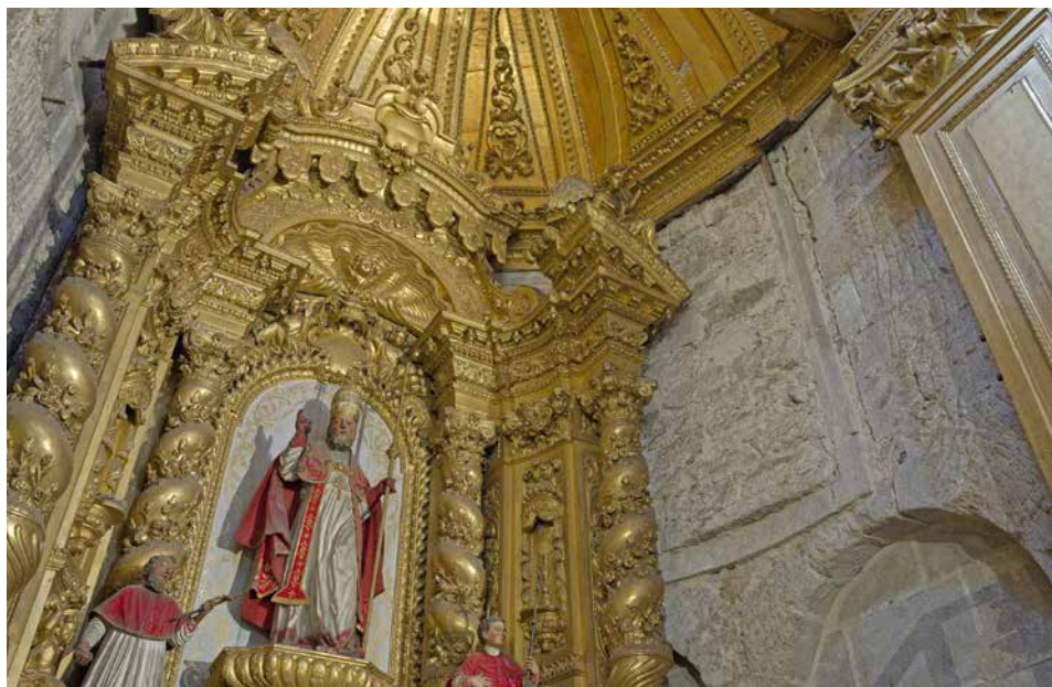
Absidiolo da cabeceira românica localizado no transepto, atual Capela de São Pedro - Arcadas cegas do alçado interno (2023, Património Cultural, I.P.©, fotografia de Carlos Sousa Pereira – DETALHAR.pt).
