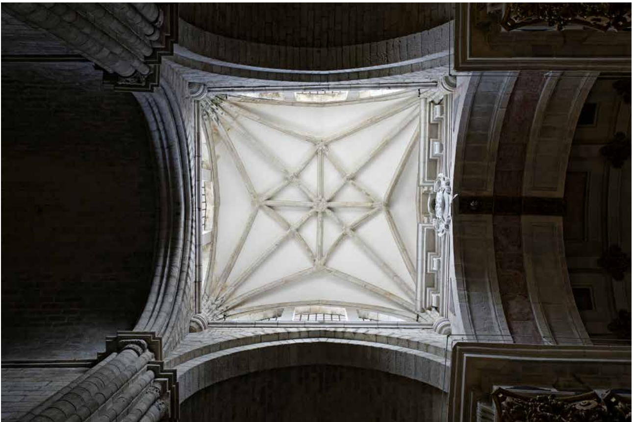
Cúpula nervada do cruzeiro da igreja, datada de 1556-1557, vista exterior e interior (2023, Património Cultural, I.P.©, fotografias de Carlos Sousa Pereira – DETALHAR.pt).
