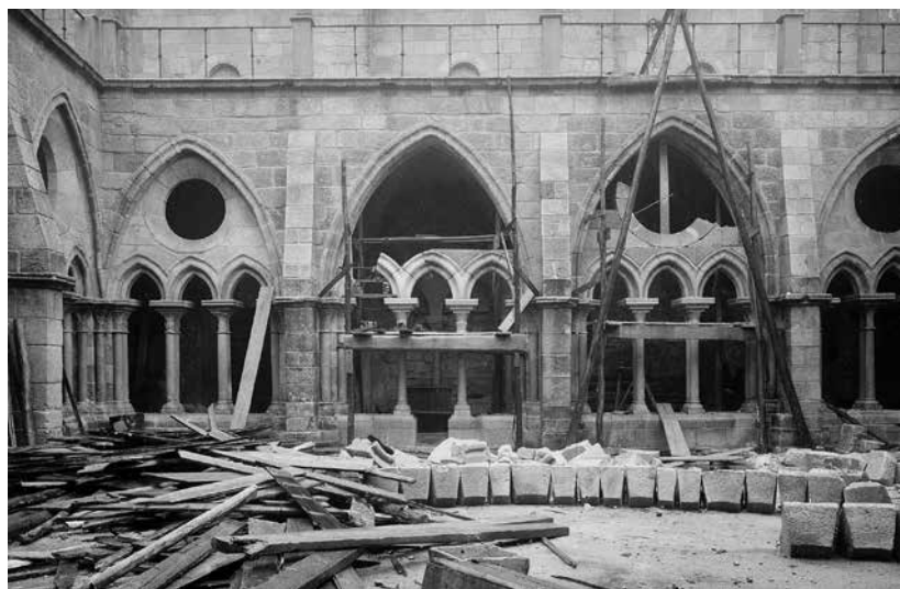
Reintegração dos antigos arcos abatidos do claustro gótico da Sé do Porto, durante a intervenção da D.G.E.M.N. (s.d., Património Cultural, I.P.©, s.a. 64 ).
