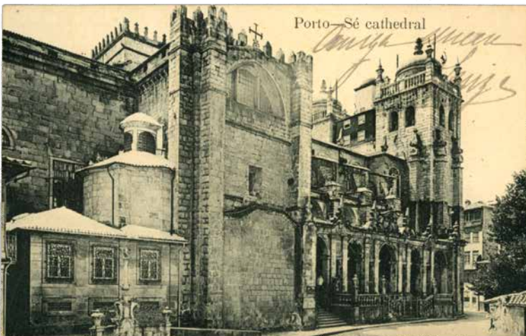
Postal da Sé do Porto, antes da intervenção da D.G.E.M.N. (s.d., Biblioteca Pública Municipal do Porto©, s.a. 61 ).
