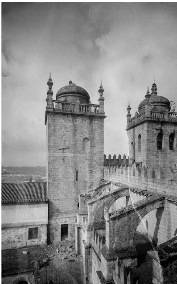
Danos provocados pela queda da cantaria do remate do coroamento da torre sul, em 1951 (s.d., Património Cultural, I.P.©, s.a. 192 ).
