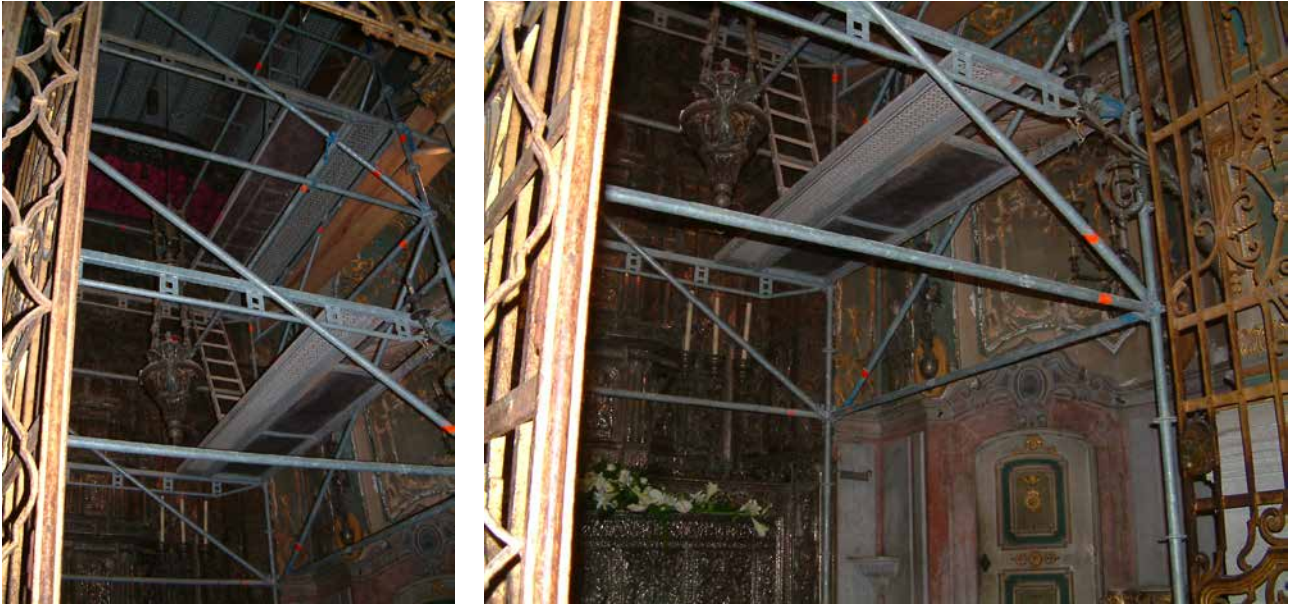
Obras de recuperação da capela do Santíssimo Sacramento (2004, fotografias de Maria Leonor Botelho©).
