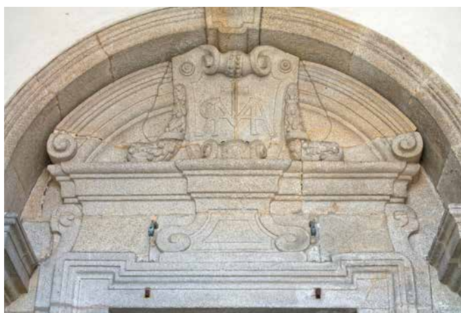
Galilé da fachada norte (2024, Património Cultural, I.P.©, fotografias de Carlos Sousa Pereira - DETALHAR.pt).
