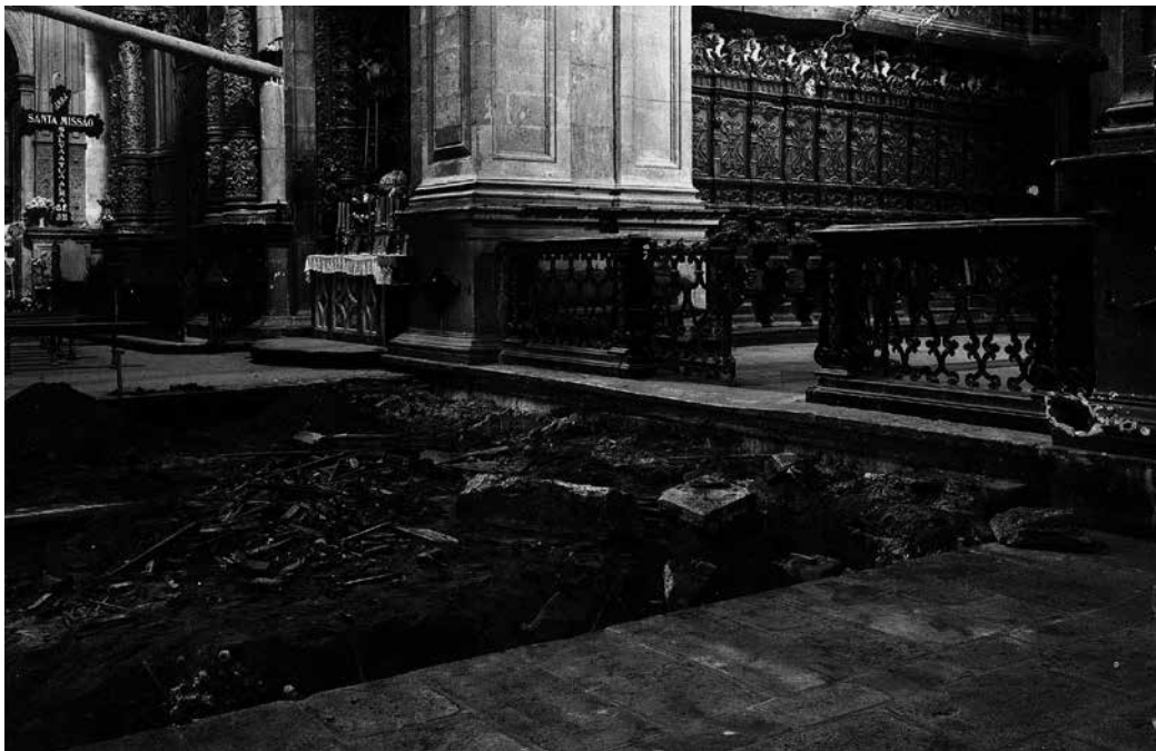
Transepto: levantamento das lajes (s.d., Património Cultural, I.P.©, s.a. 169 ).
