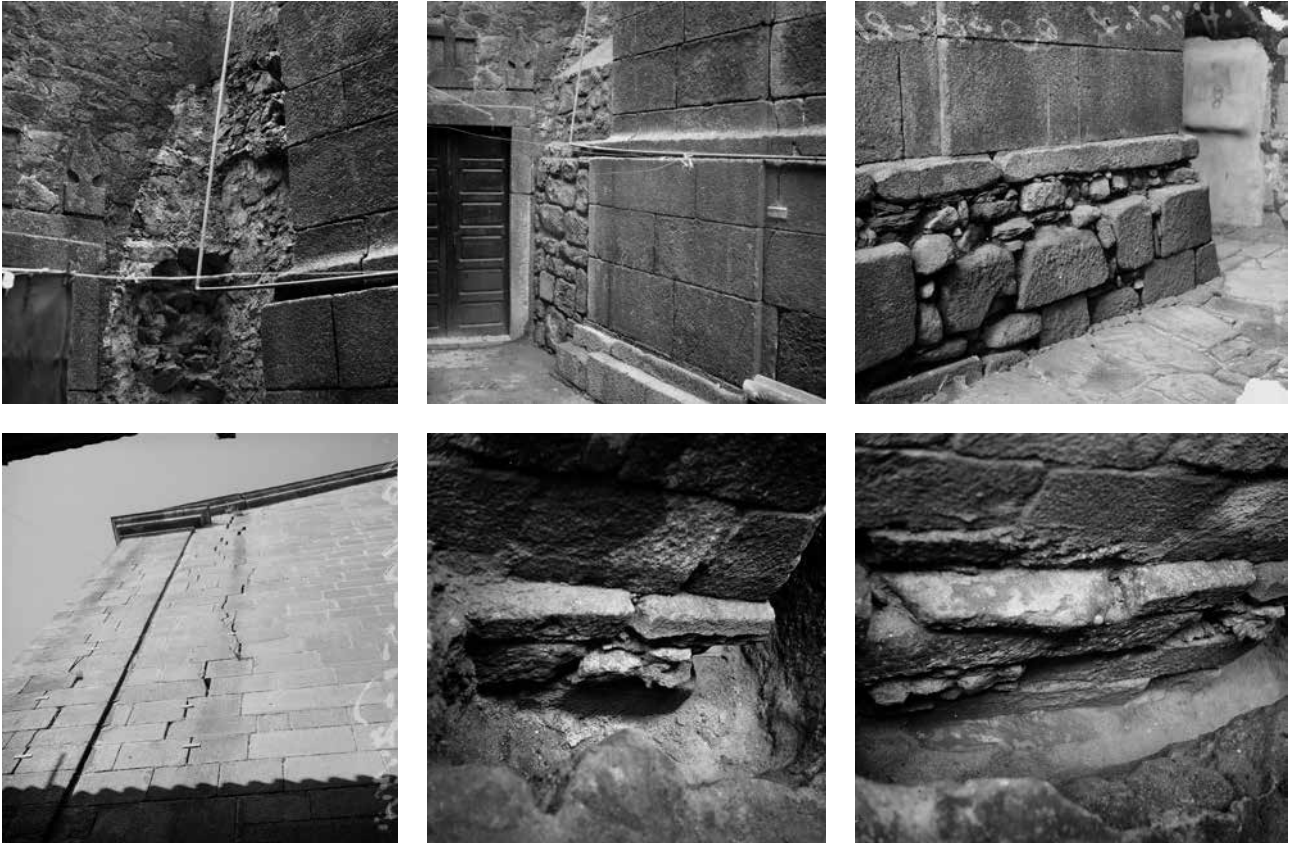
Aspeto da realização de sondagens às fundações, reconstrução do soco exterior e consolidação da cabeceira da Sé do Porto, durante a intervenção da D.G.E.M.N. (s.d., Património Cultural, I.P.©, s.a. 149 ).
