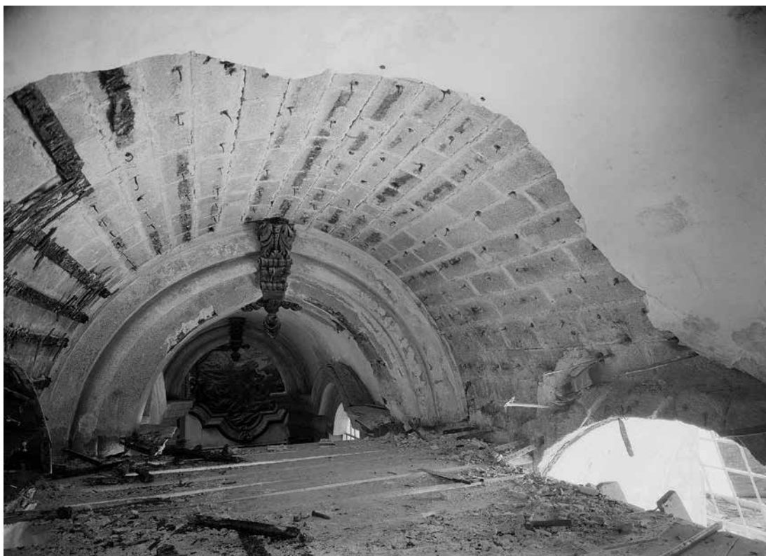
Teto durante as obras da D.G.E.M.N. (s.d., Património Cultural, I.P.©, s.a. 199 ).
