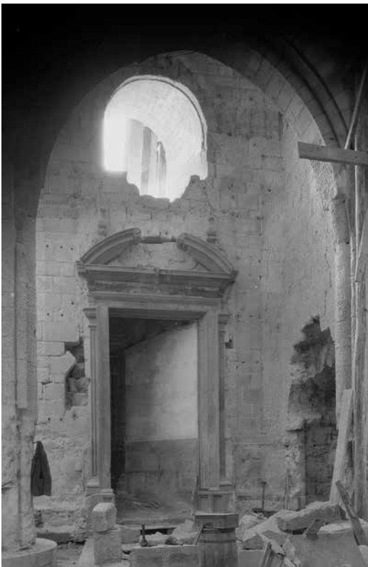
Transepto: pormenor das obras junto à porta (s.d., Património Cultural, I.P.©, s.a. 167 ).
