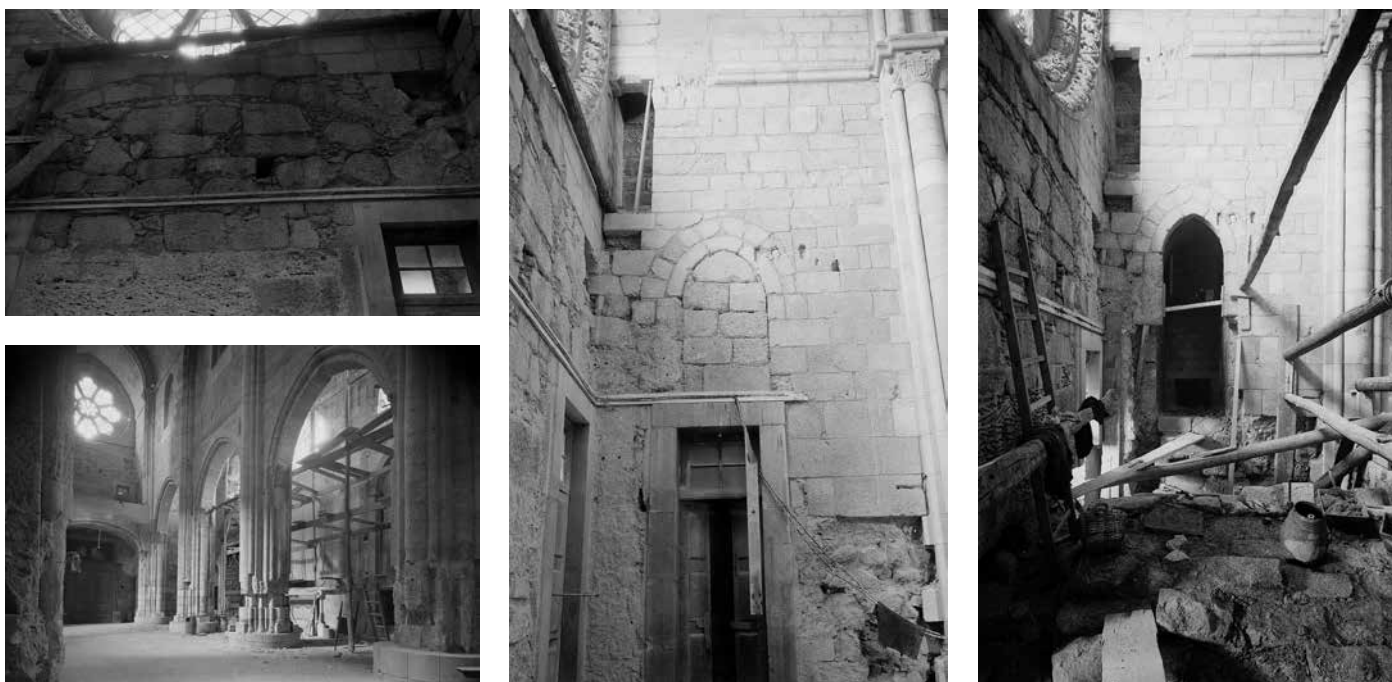
Vestígios de arco emparedado; interior de parede com arco emparedado; obras no interior do coro alto (s.d., Património Cultural, I.P.©, s.a. 298 ).
