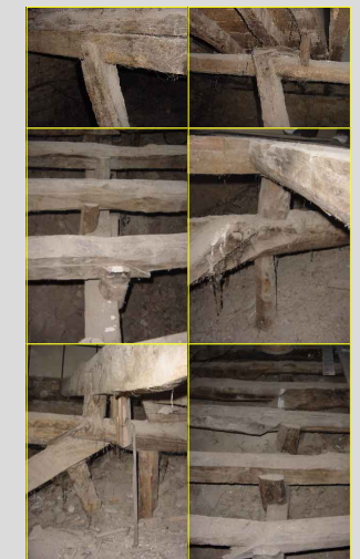
SALA ENTRE TORRES SINEIRAS
