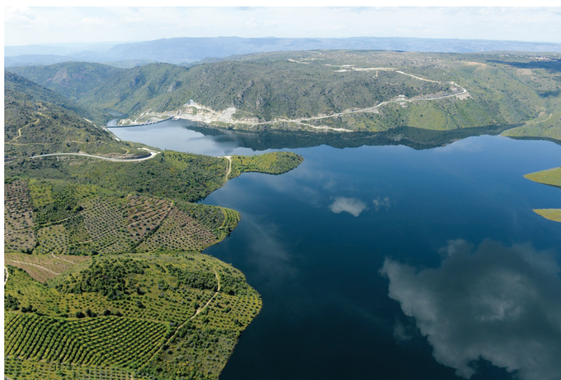
Fig. 2 – Albufeira do escalão de montante do Aproveitamento Hidroelétrico do Baixo Sabor.
