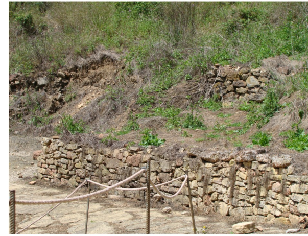
Muro lateral - Estrutura 101
