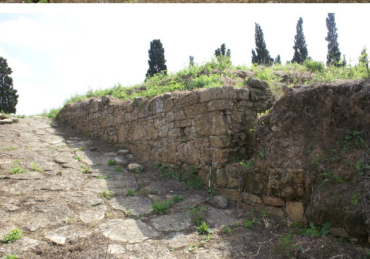
Rua a oeste do Templo Reconstrução de muros que ladeiam a rua Consolidação da casa Juntas, limpeza
