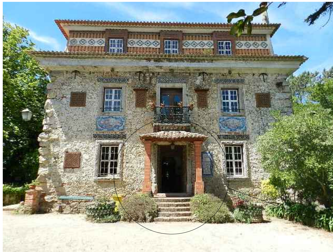
VISTA GERAL DO EDIFÍCIO
