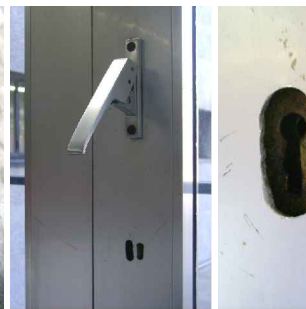
04/05 - FURAÇÃO DO PERFIL DE ALUMÍNIO
